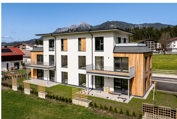
Außenansicht Haus A
