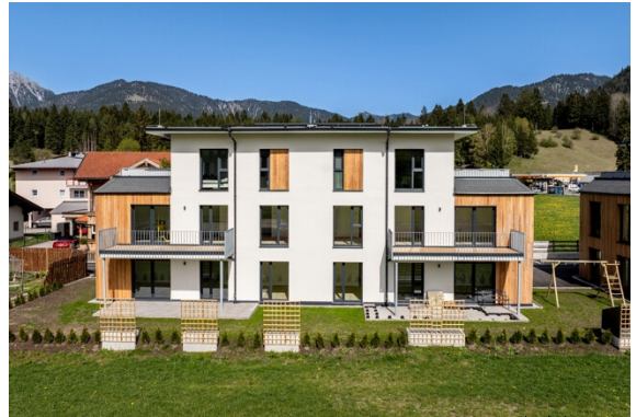
Außenansicht Haus A
