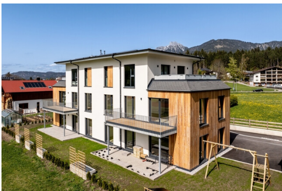
Außenansicht Haus A
