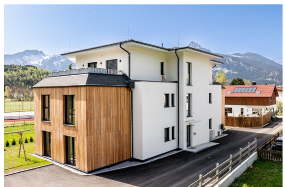
Außenansicht Haus A
