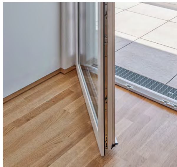
barrierefreie Zugänge auf Balkone und Terrassen
