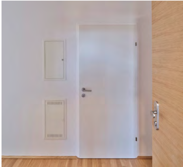
einbruchhemmende Wohnungstüren durch Sicherheits-Schließanlage
