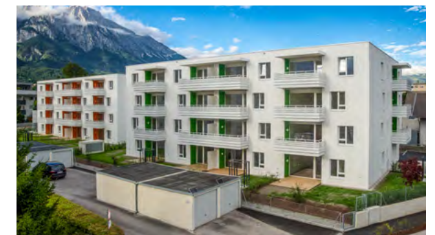
Wohnanlage — Domizil — Hall in Tirol
