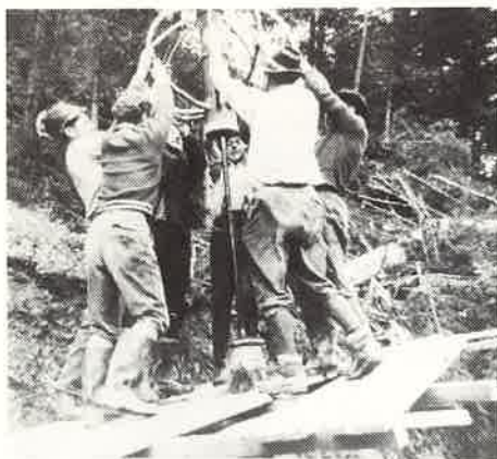
Pilotenschlagen – Triebentalbachverbauung.
