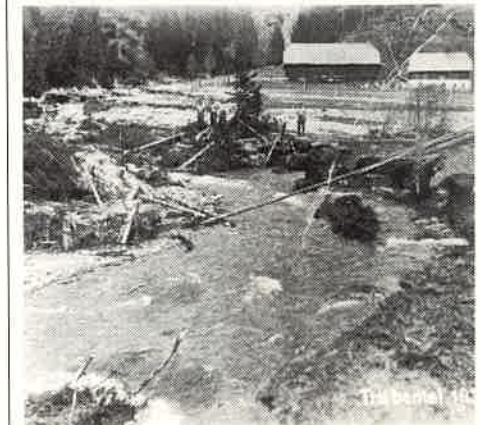
Hochwasser 1938 im Triebental (Königsbach).
