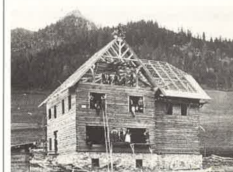
Rohbau der Volksschule in Hohentauern, 1910.
