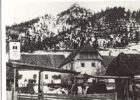
Triebensteiner Bartholomäuskirche, Getreidespeicher und Wirtsmühle (1898).
