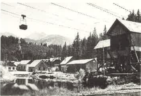
Magnesitbergbau mit Seilbahn-Winkelstation.
