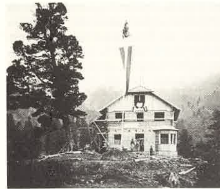
Bau der Edelrautehütte.
