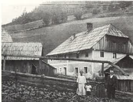
Alte Mühle beim Obermühler (Kohlhubengut).
