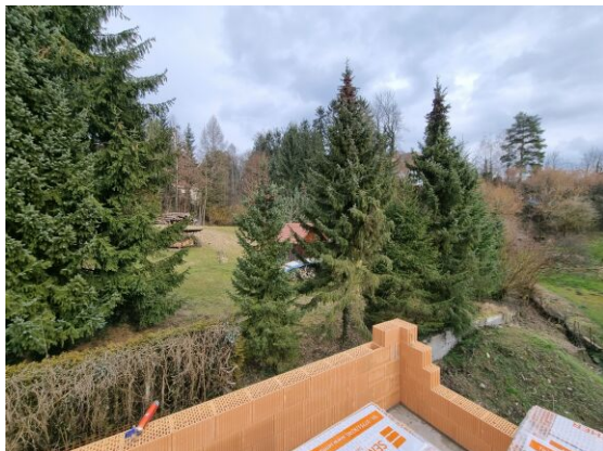
Baufortschritt - Mauern im 1.OG
